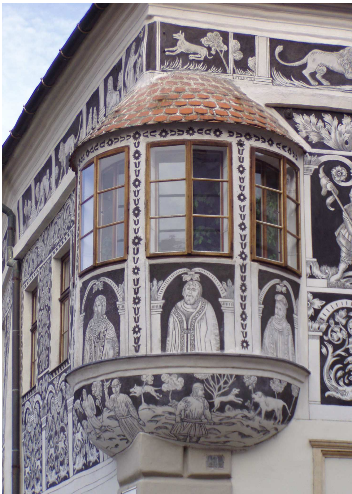
13/ Arkýř Malovaného domu konec 16. století, obnoveno 1903 pohled od severozápadu
