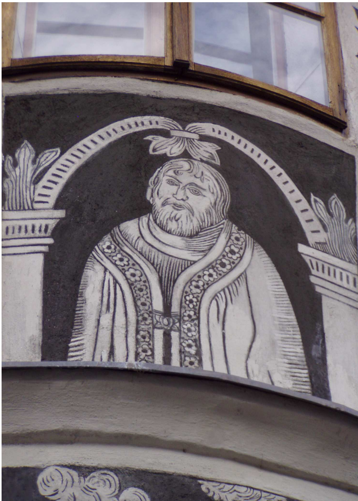
16/ Výzdoba arkýře - detail konec 16. století, obnoveno 1903 sgrafito Třebíč, Malovaný dům
