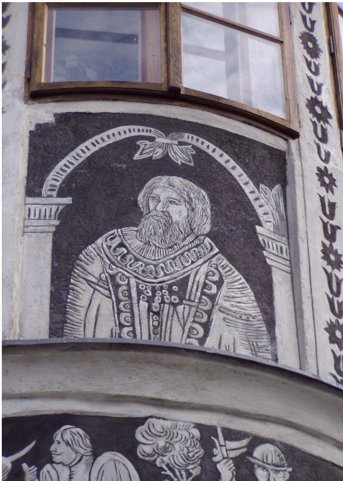
15/ Výzdoba arkýře - detail konec 16. století, obnoveno 1903 sgrafito Třebíč, Malovaný dům
