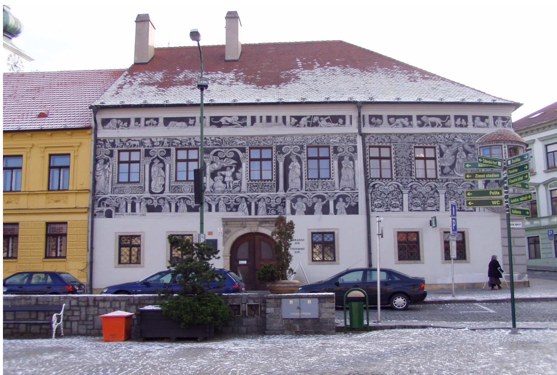
2/ Třebíč, Malovaný dům – průčelní fasáda konec 16. století pohled od severu
