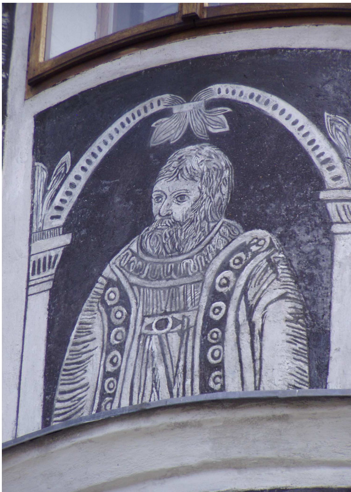
14/ Výzdoba arkýře - detail konec 16. století, obnoveno 1903 sgrafito Třebíč, Malovaný dům
