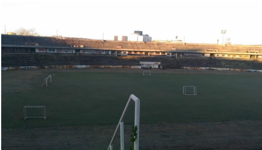
Obr. č. 10: Stav hrací plochy fotbalového stadionu Za Lužánkami (zdroj: studentské foto)
