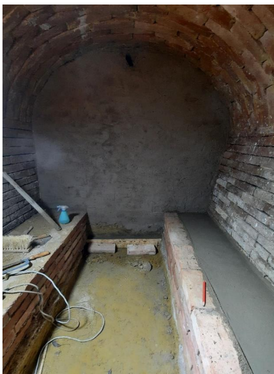
Obrázek 11: Stavba zděného sklepa. Nížkovice. Foto M. Robešová, 2021.
