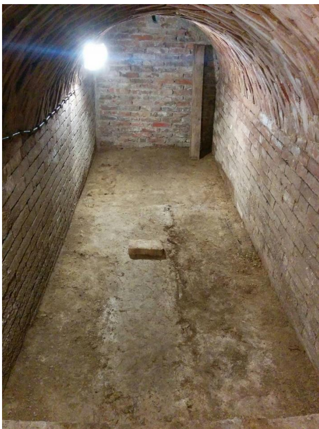
Obrázek 12: Výstavba sklepa. Nížkovice. Foto M. Robešová, 2022.
