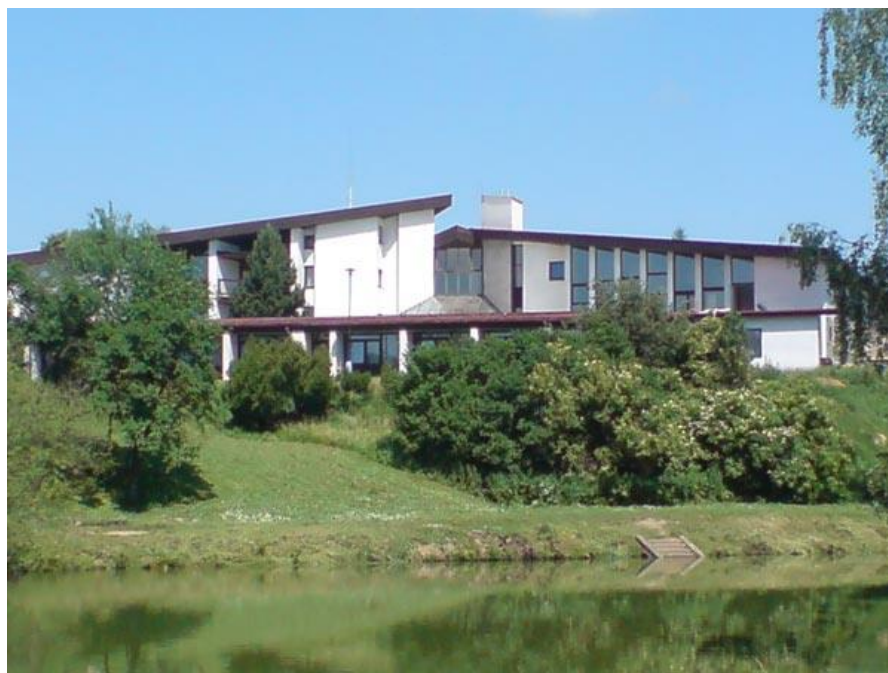
Obrázek č. 1, ubytovací zařízení Vyhlídka.
