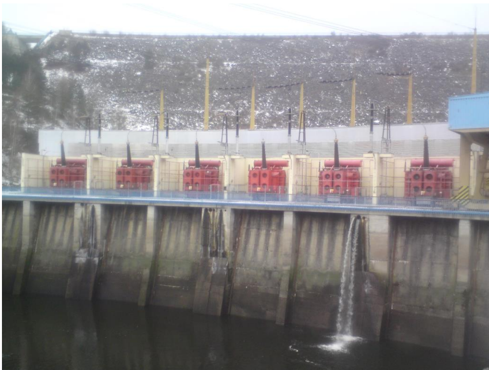
Obr. A. Strojovna elektrárny a hráz Vodního díla Dalešice. (zdroj: autor)
