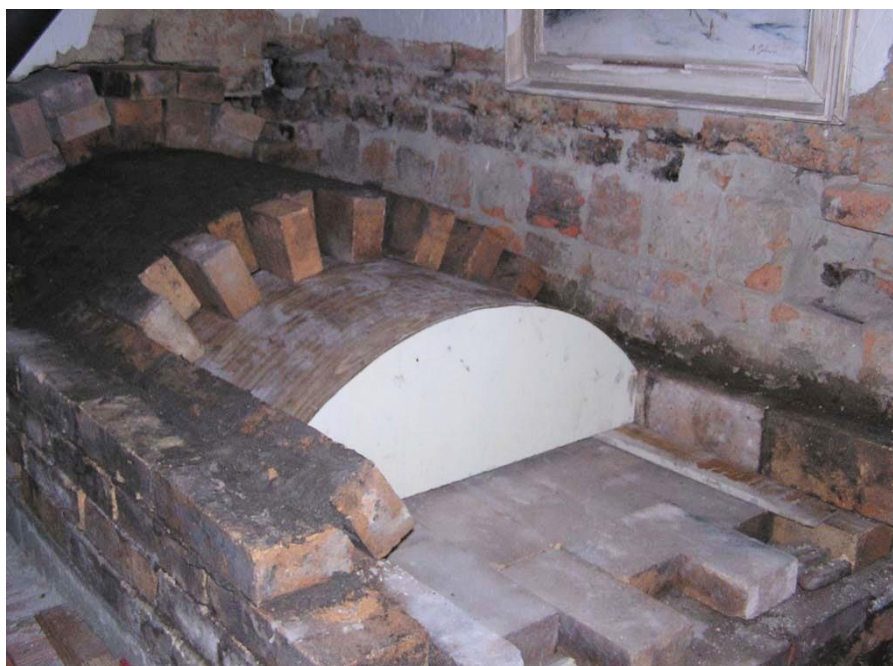
(obr. 4, jeden ze způsobů stavění klenby )
