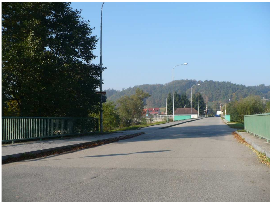
(9) Nově vybudovaný most nad řekou Svitavou spojující Doubravici a Klemov (opravy proběhly v roce 2001)
