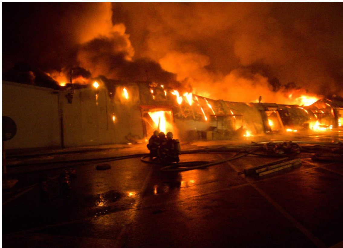
Požár velkého rozsahu – tržnice Olomoucká, Brno 2011.
