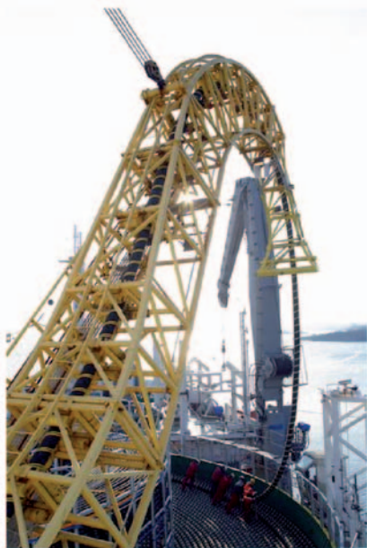
Obrázok 25.7 Ukladanie vysokonapäťového DC spojenia medzi Fínskom a Estónskom. Dvojica týchto káblov prenáša výkon 350 MW. Fotografia: ABB.
