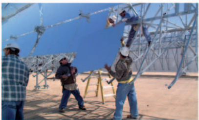
Obrázok 25.4 Andasol – rozostavaná „100 MW“ solárna elektrárň v Španielsku. Nadbytočné teplo vyrobené cez deň sa uloží v nádržiach s tekutou soľou až na sedem hodín a zásobuje sieť nepretržitým a stabilným elektrickým výkonom. Elektrárň by mala podľa predpokladov vyrábať 350 GWh za rok (40 MW). Parabolické žľaby zaberajú 400 hektárov, preto výkon na jednotku plochy krajiny bude 10 \text{ W/m}^2 . Horná fotografia: ABB. Nižšia fotografia: IEA SolerPACES.
