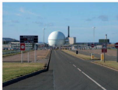
Obrázok 24.5 Jadrové vývojové zariadenie v Dounreay, ktorého hlavným účelom bolo vyvinúť technológiu rýchleho množivého jadrového reaktora. Fotografia: John Mullen.
