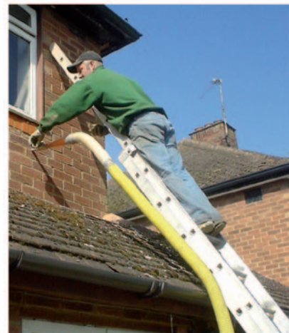
Obrázok 21.5 Tepelná izolácia stien z dierovaných tehál.
