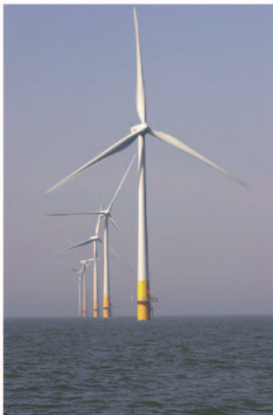
Obrázok 10.1 Kentish Flats – morský veterný park v plytkom mori. Každý rotor má priemer 90 m so stredom vo výške 70 m. Každá „3 MW“ turbína má hmotnosť 500 ton, pričom polovica z nej je v základoch. Fotografie: © Elsam (elsam.com). Použité s povolením.
