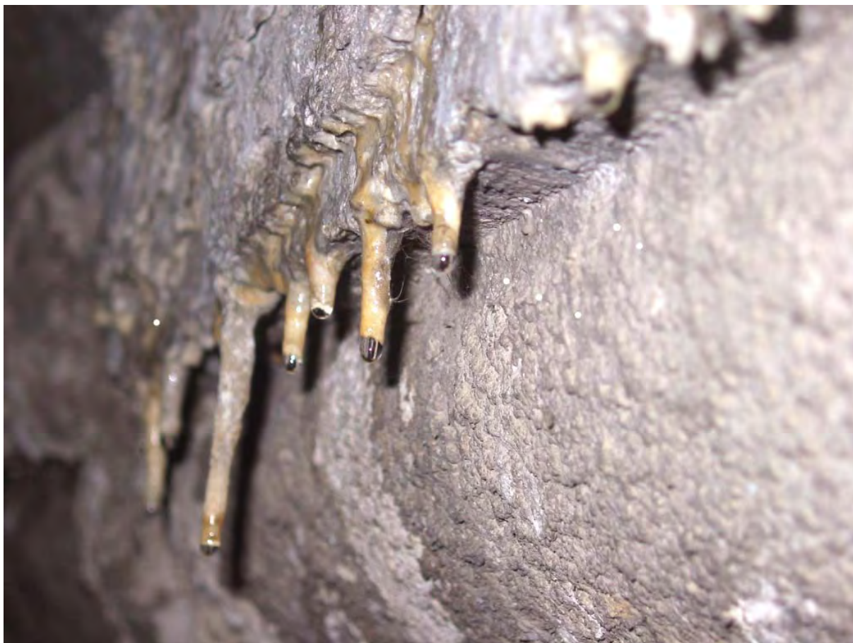
Foto č. 1: Krápníková výzdoba na železničním viaduktu v Brně (foto J., Nezvalová, 2002).
