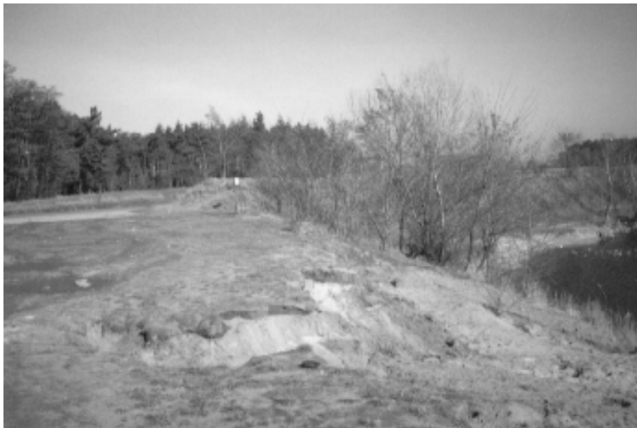
Obr. č. 1 - Eroze břehů lomového jezera ve Šnepově
