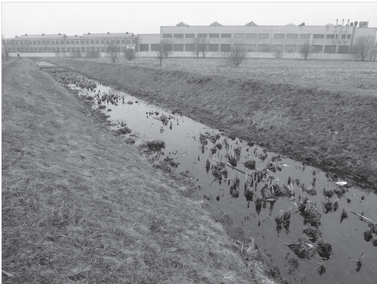
Obr. 4: Regulované koryto Lačnovského potoka před soutokem s řekou Svitavou v období vegetačního klidu (foto: Slabá 2013)
