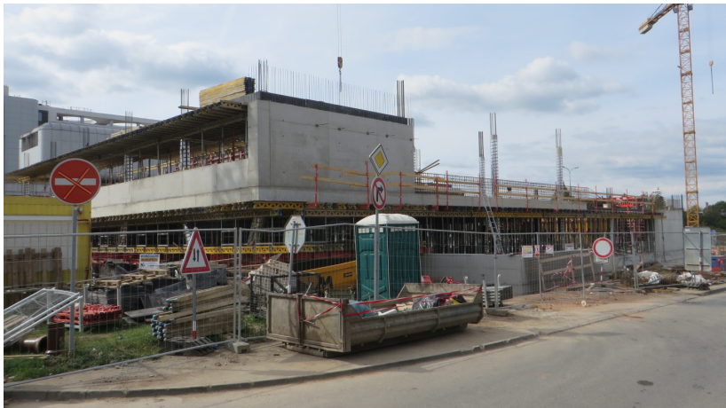
Litý železobeton, stavba SIMU+
