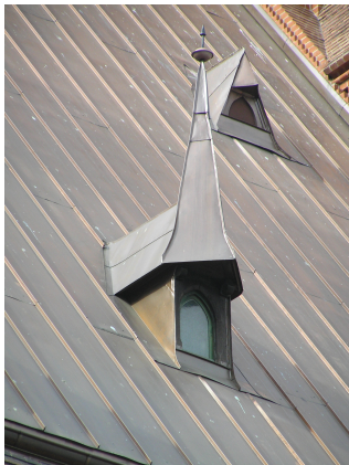
Střecha z pozinkovaného plechu. 54
